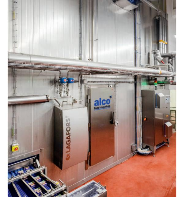
Über 35,5 Etagen kühlt der Spiralkühler bei Reinert die Ware von 76°C auf 5°C herunter.
